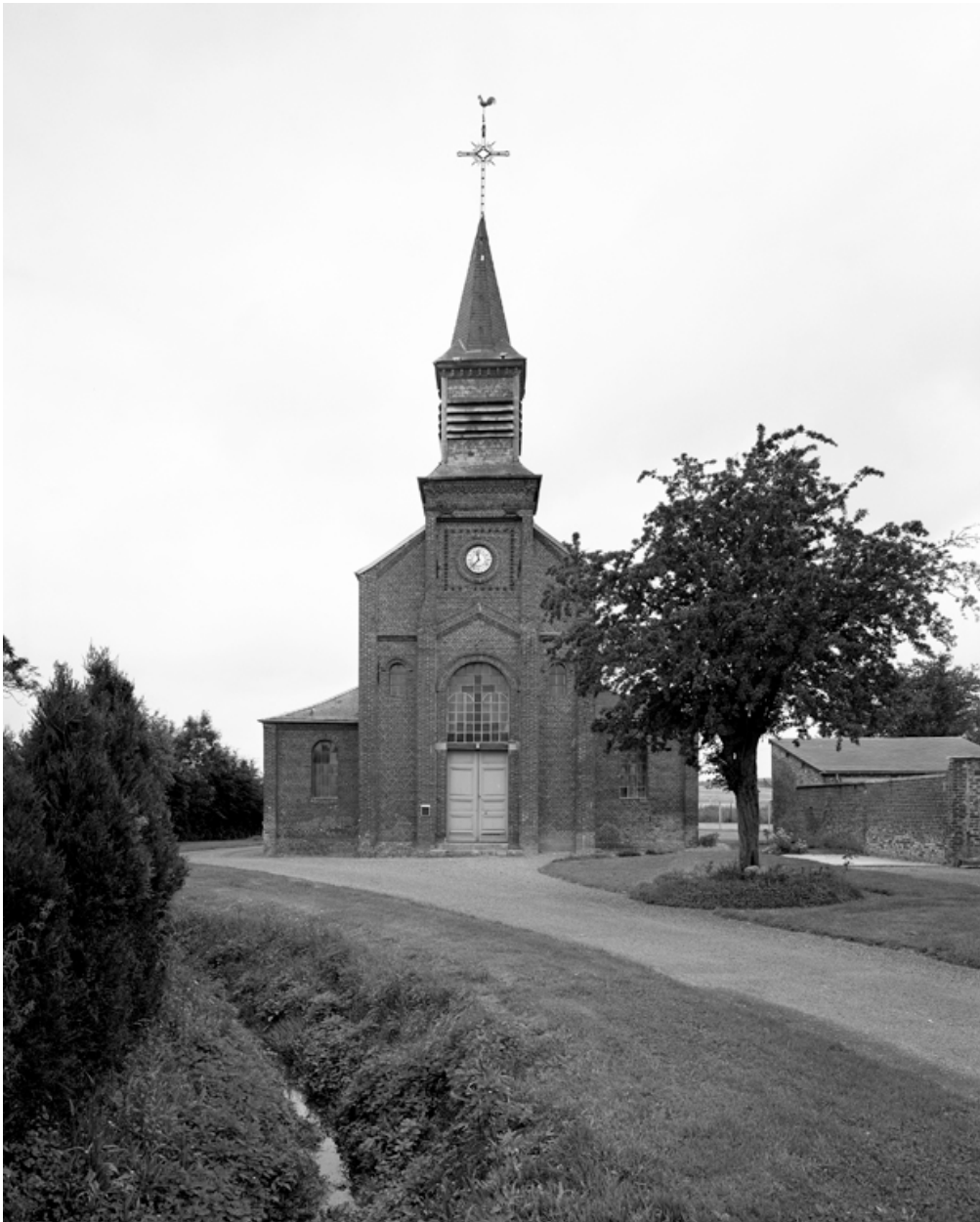
Vue générale de la façade.
