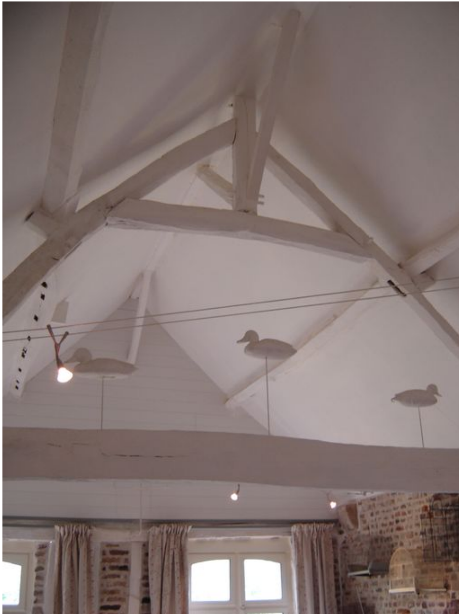
Vue détaillée d'une ferme de la charpente de la grange.
