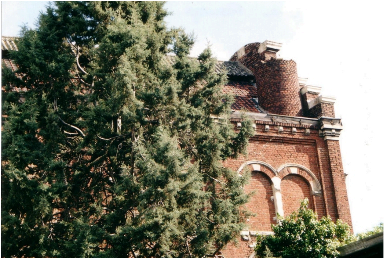
Façade sur cour des ateliers, 1996 (BM Saint-Quentin).
