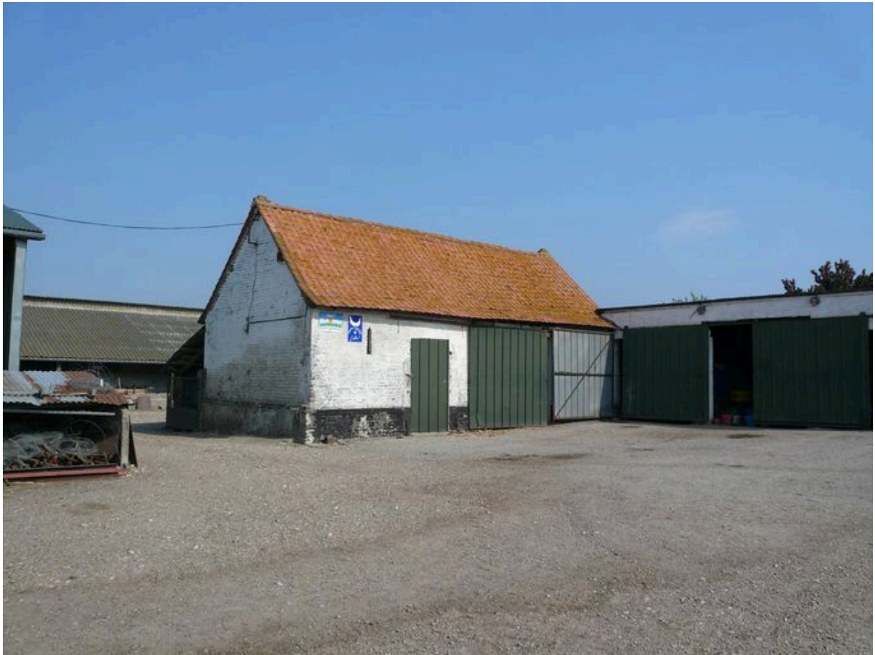
Vue de l'écurie à l'est de la cour.
