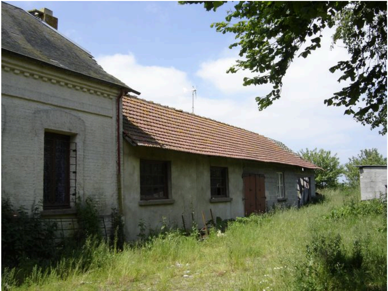
Vue des bâtiments annexes dans le prolongement du logis.
