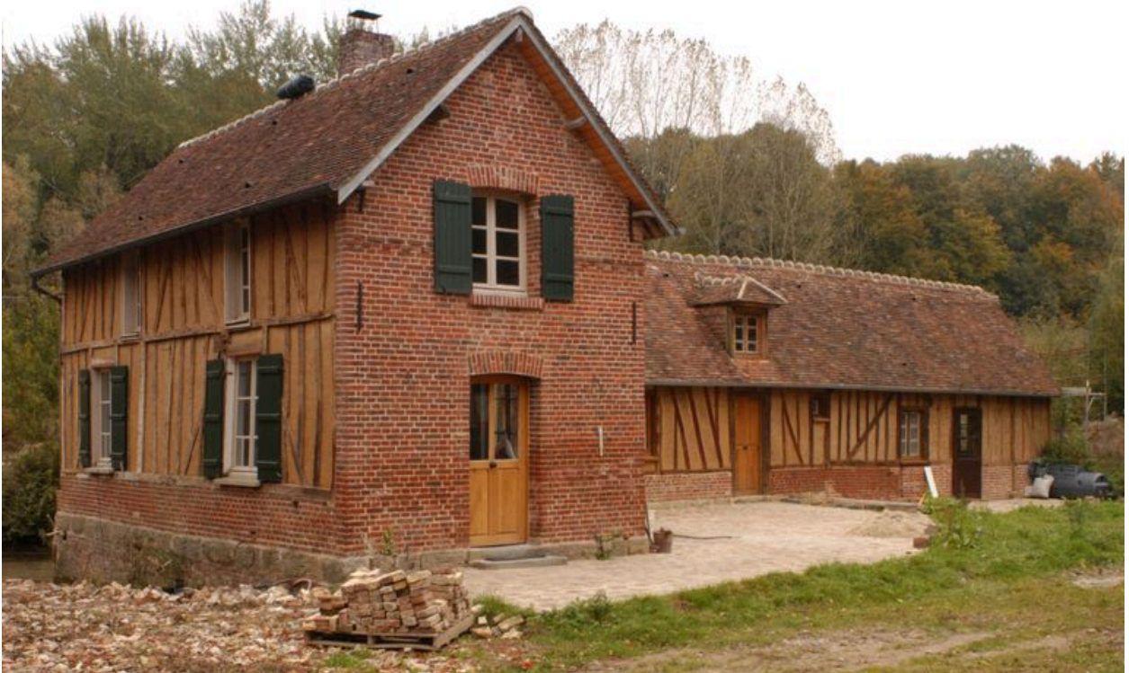
Vue d'ensemble sud des étables et des écuries.
