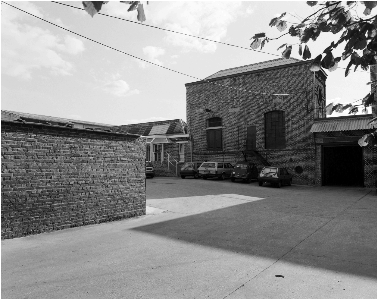
Salle des machines, élévation sur cour.
