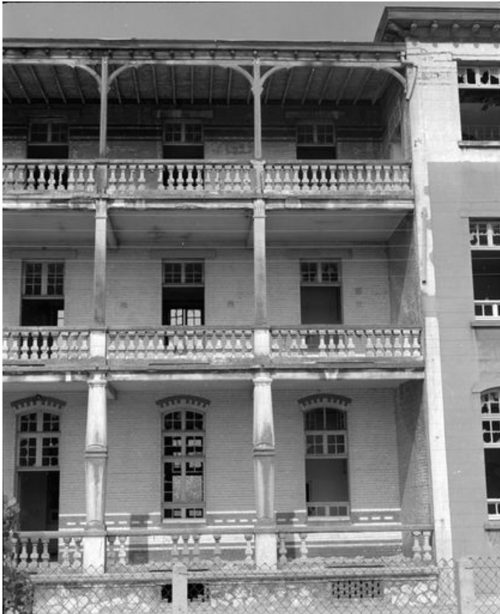
Façade donnant sur la rue où se déploient les galeries de cure, détail des galeries de cure superposées.
