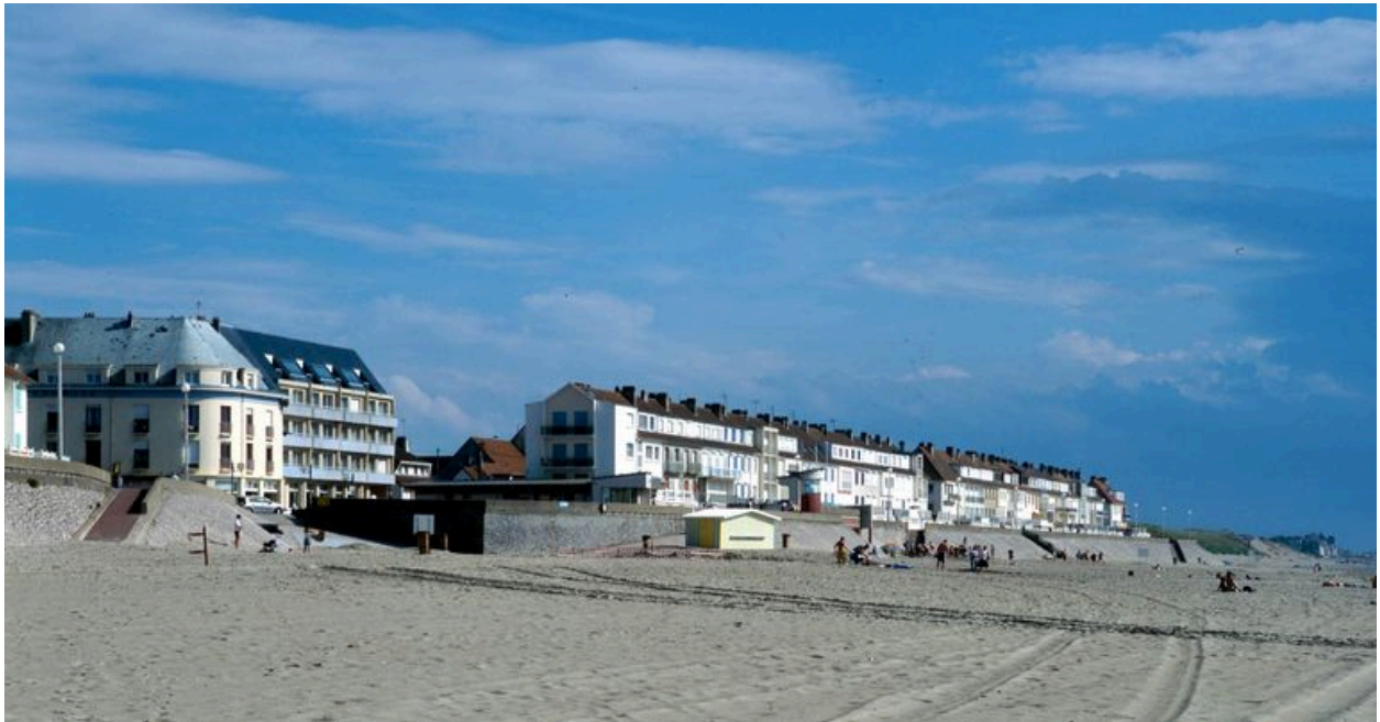
Le front de mer de Fort-Mahon-Plage : vue d'ensemble de la digue sud, depuis le nord.
