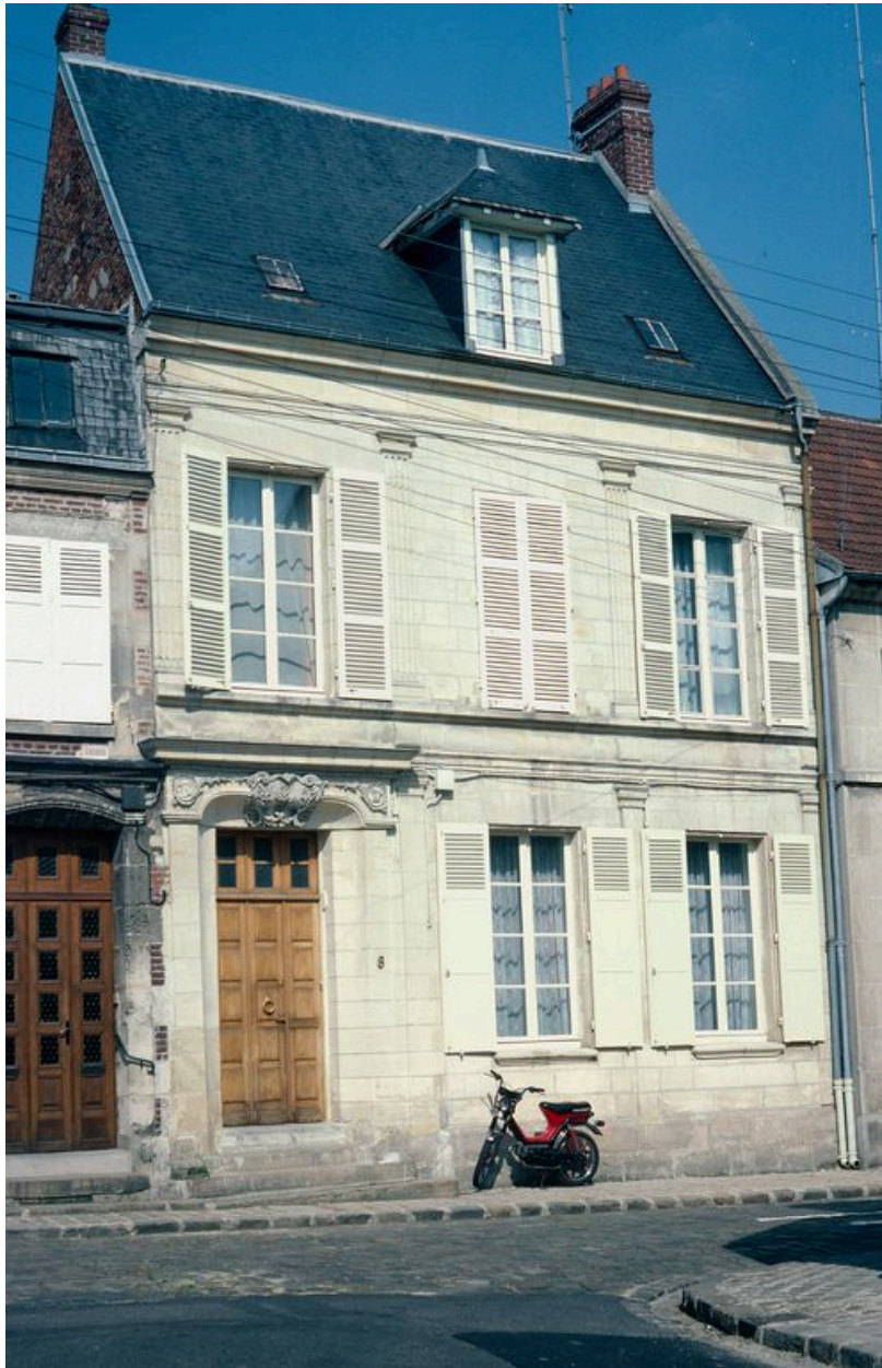
Elévation sur rue, de léger trois-quarts.
