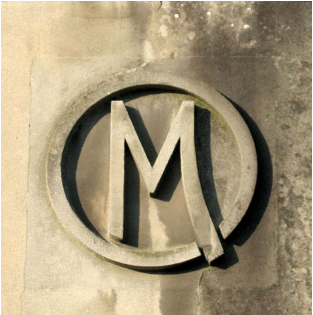
Monogramme M pour Marinoni sur le transformateur électrique.
