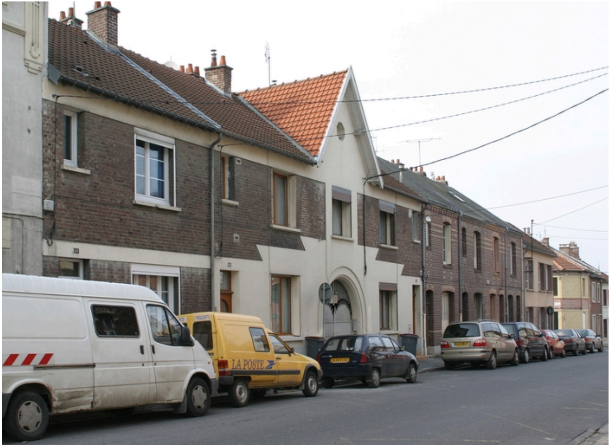
Façade antérieure sur rue.
