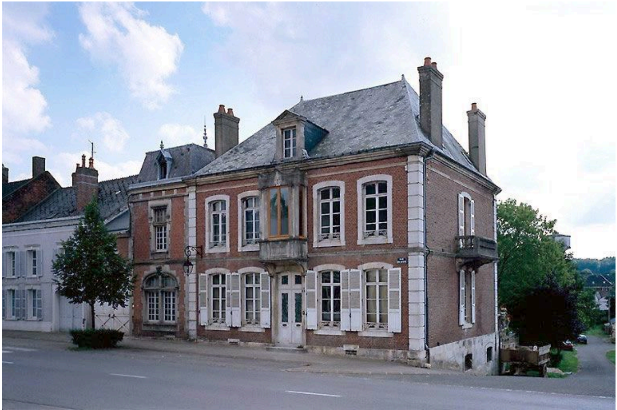
Elévation sur rue depuis le sud-ouest.
