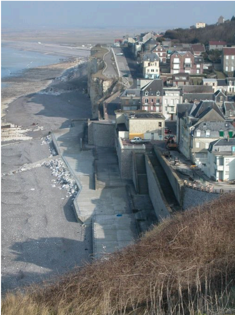
La digue en amont du casino.
