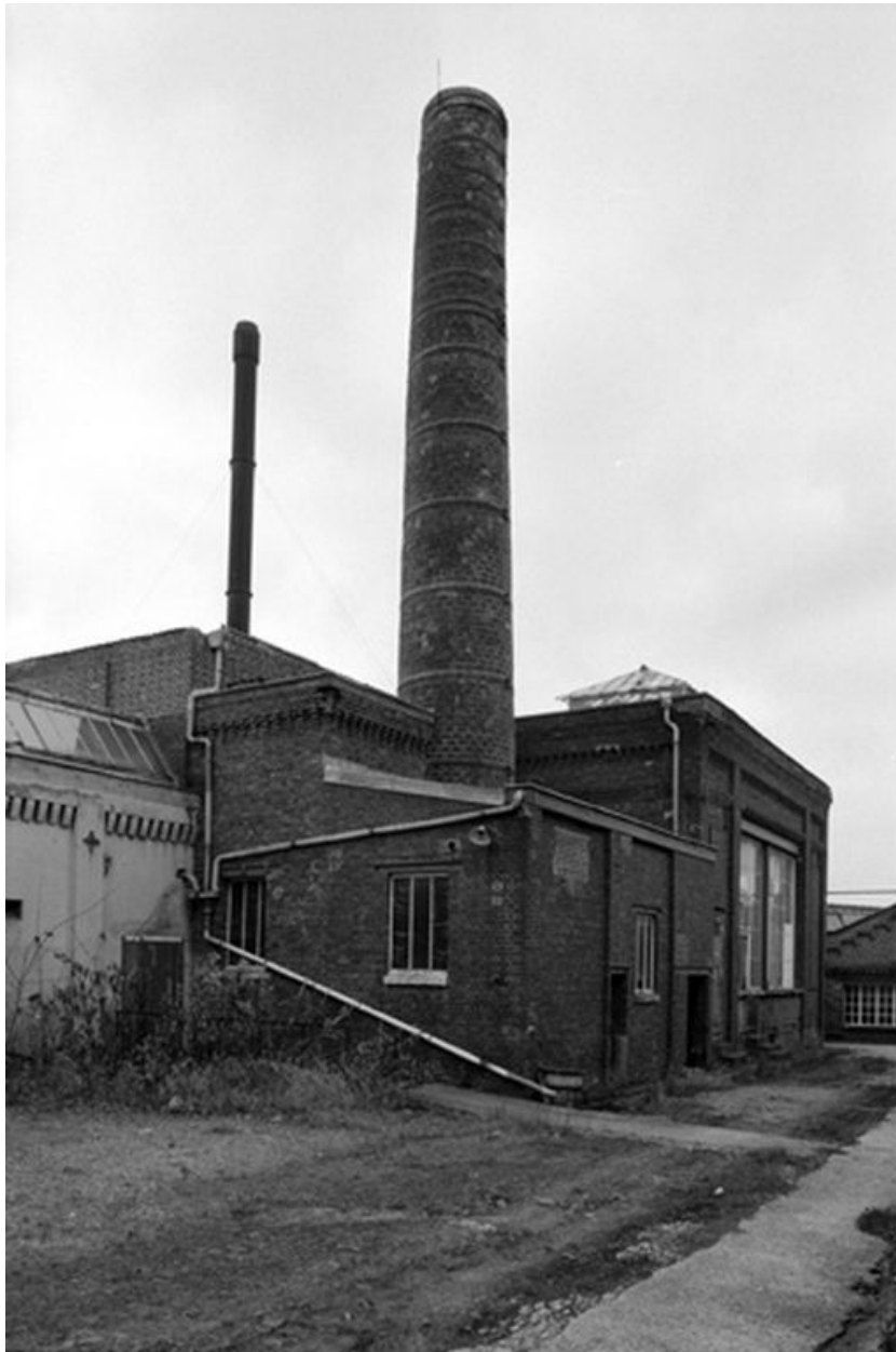
Chaufferie, salle des machines et cheminée d'usine, flanc nord-est en 1987.
