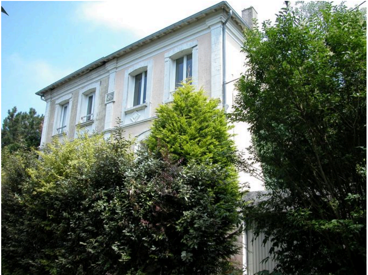
Vue de trois-quarts, façades sud et est.
