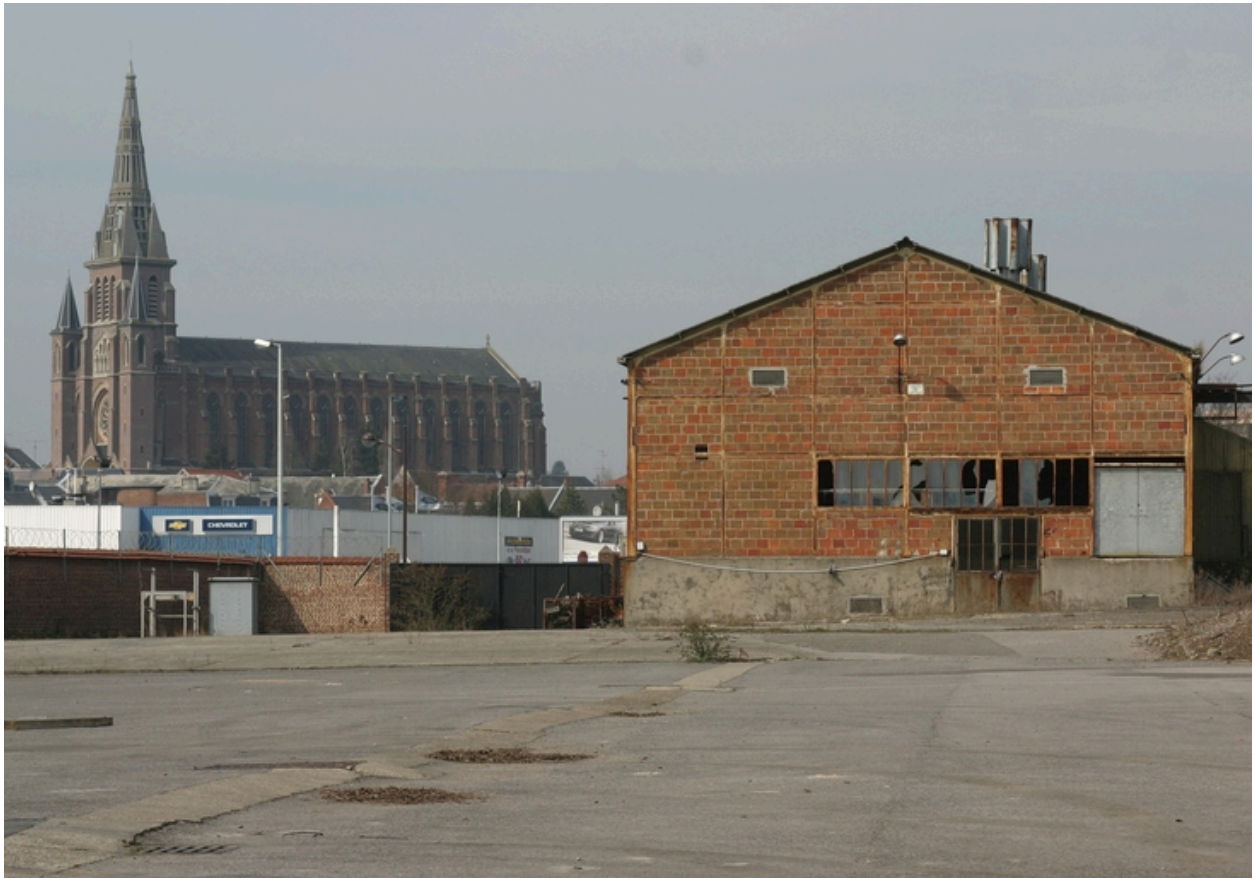
Atelier postérieur à 1919, implanté en bordure de la rue Delavenne. A l'arrière plan, l'église Saint-Martin.
