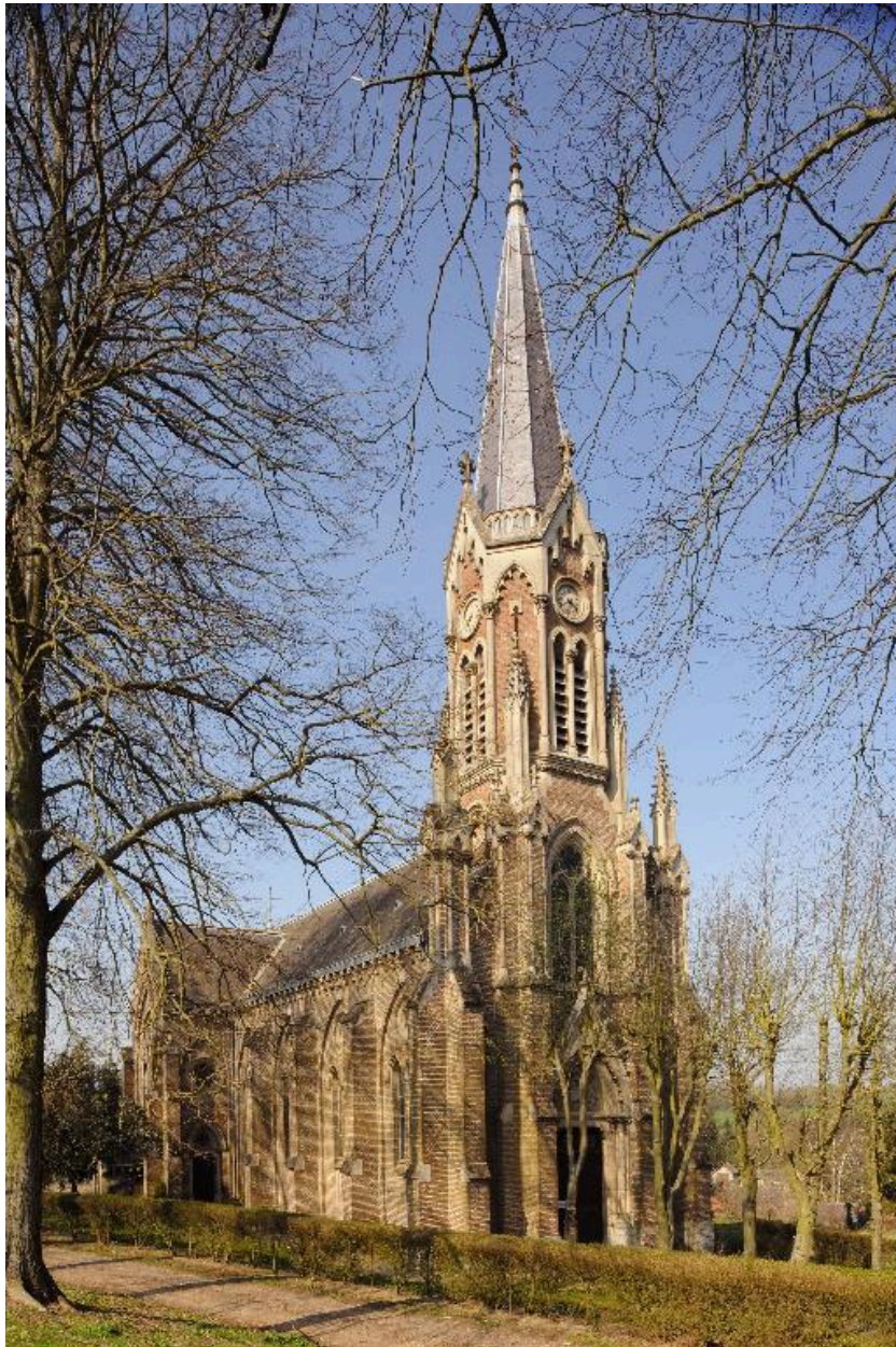
Vauchelles-lès-Domart, église paroissiale Saint-Nicolas, Paul Delefortrie architecte (?), 1877-1882.
