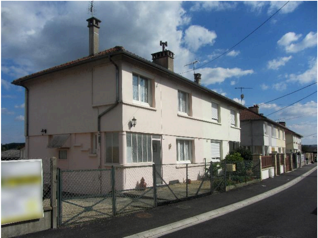
Maisons de la cité Maguin, construite en 1956 (rue Alexandre-Dumas).
