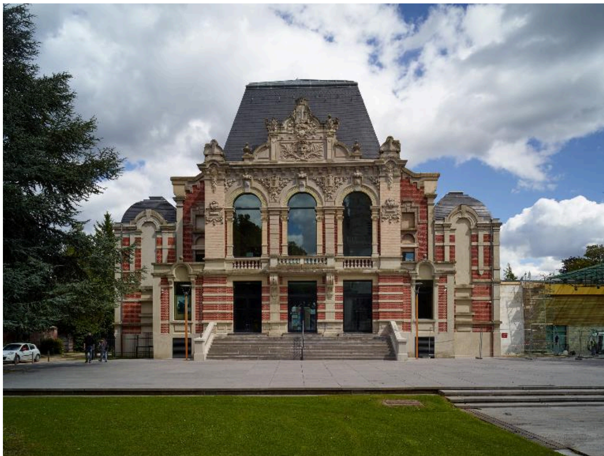
Vue générale depuis le jardin public.
