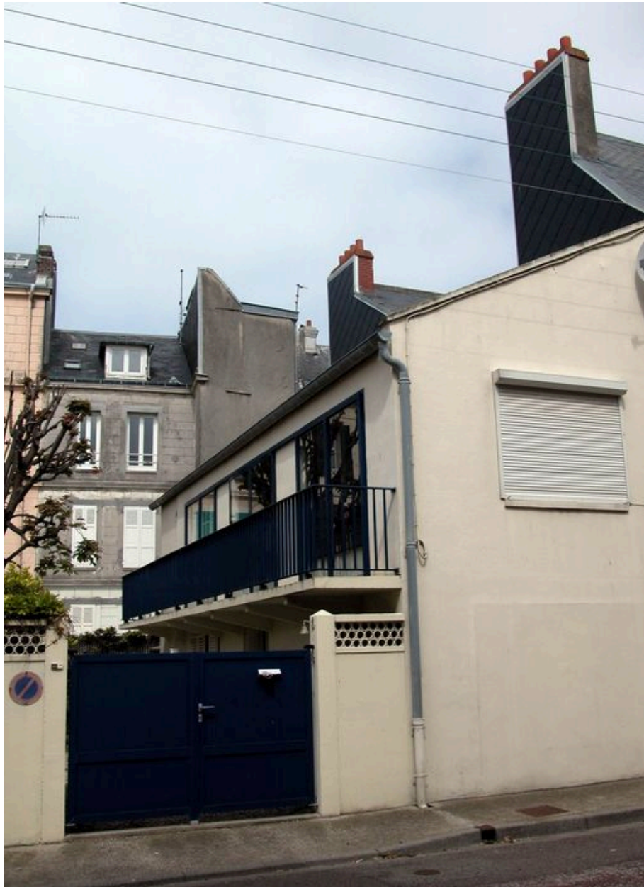
Aménagements tardifs, 24 rue Henri-Leboeuf (1982 AH 957).
