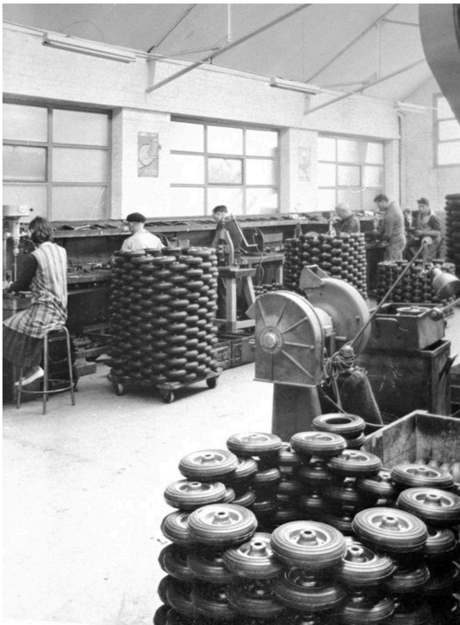
Intérieur de l'atelier d'assemblage des bandages sur le moyeux, vers 1970 (AP).
