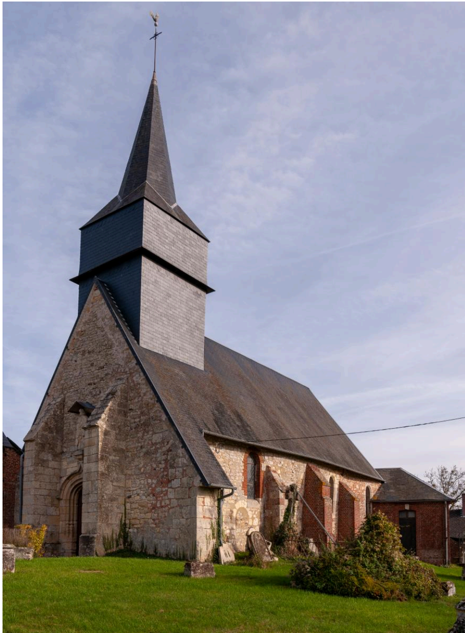
Vue de l'église depuis le nord-ouest.
