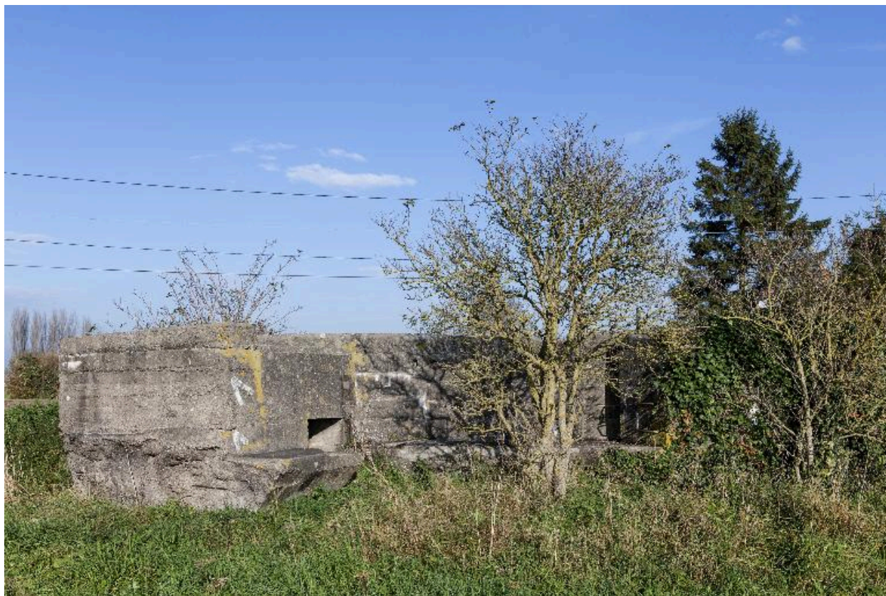
Vue générale vers nord-est
