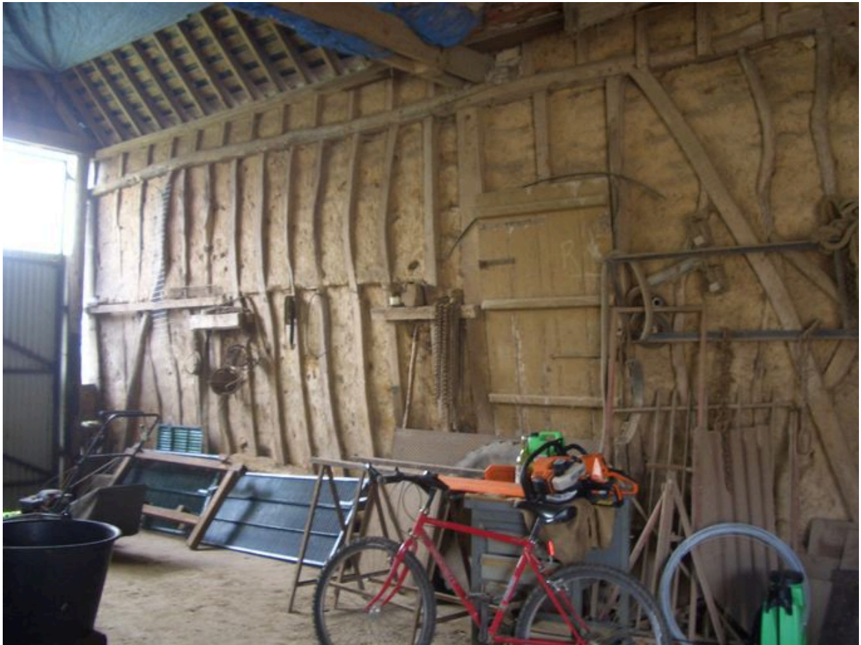
Vue intérieure de cette grange avec réhaussement des pans de bois.
