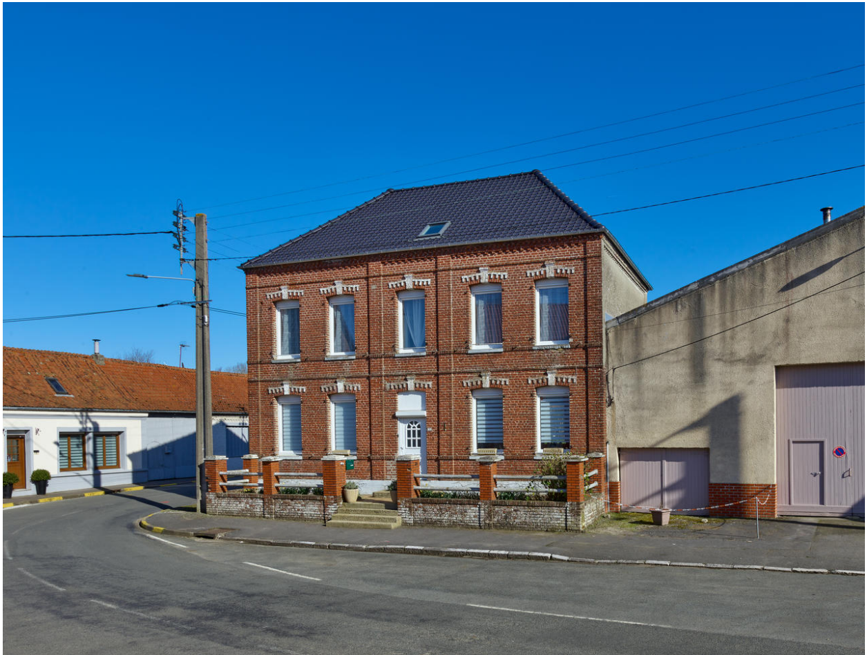
Vue générale de l'élévation antérieure.
