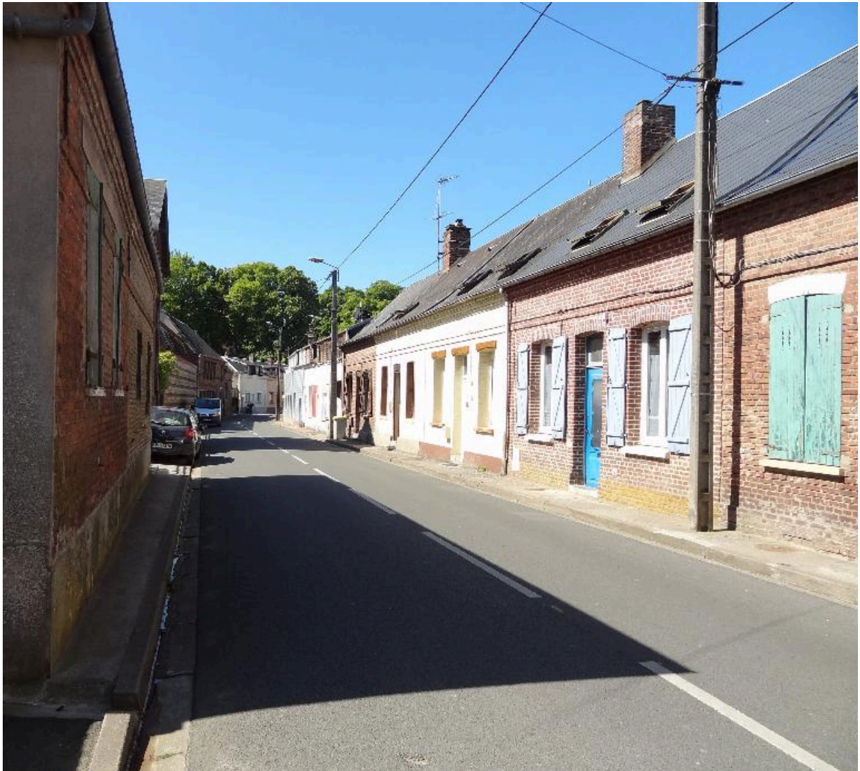
Ancienne cité ouvrière Gaudefroy-Caqueret, rue Jean Catelas.
