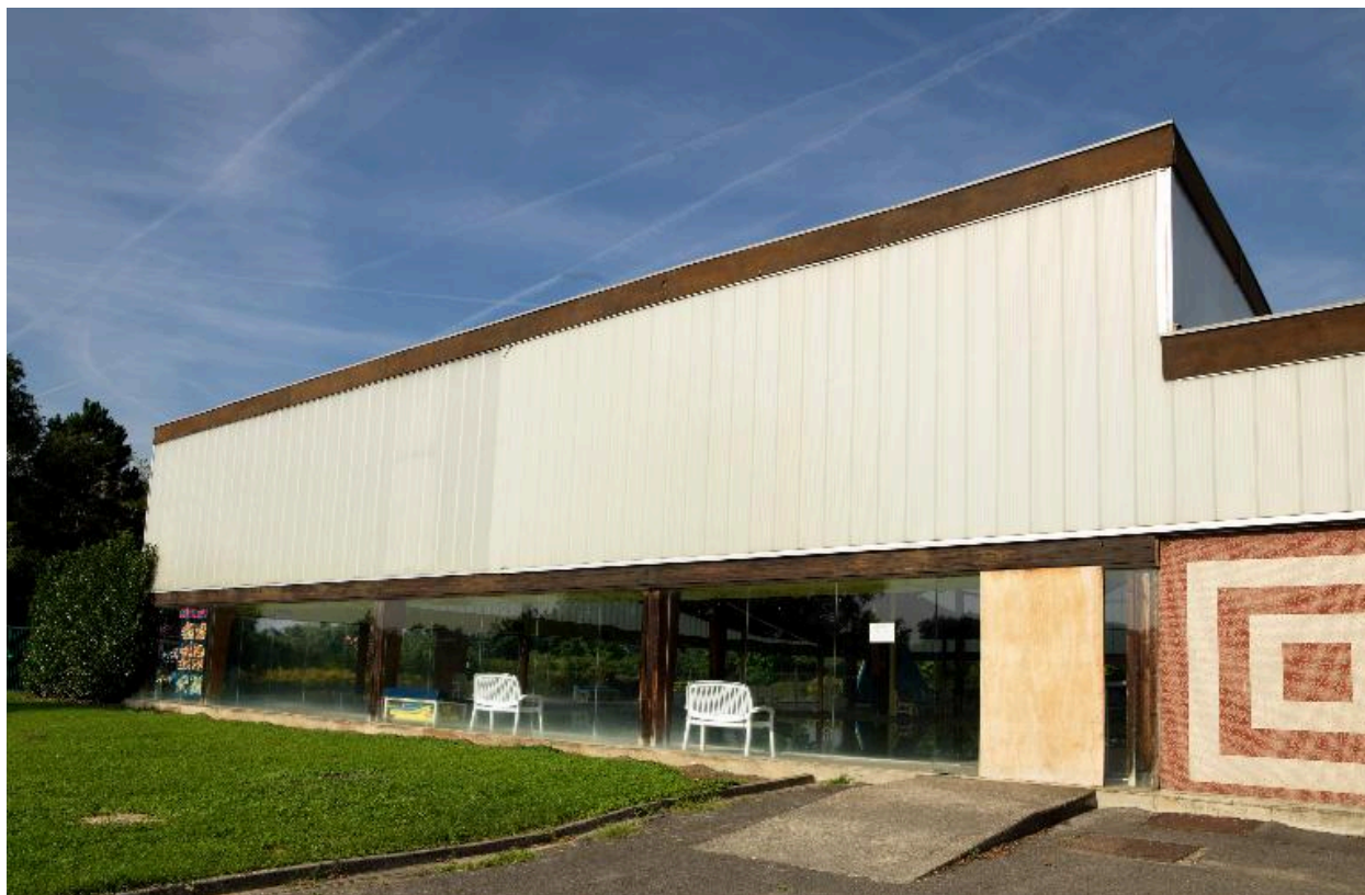
Façade donnant sur le petit bassin (est).
