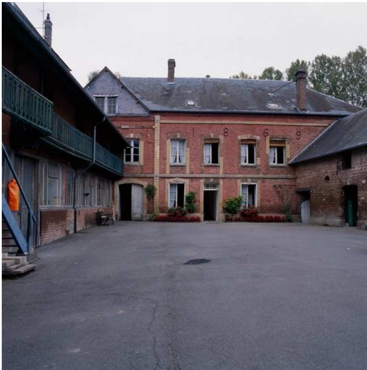
Le logement construit en 1869, façade sur cour.
