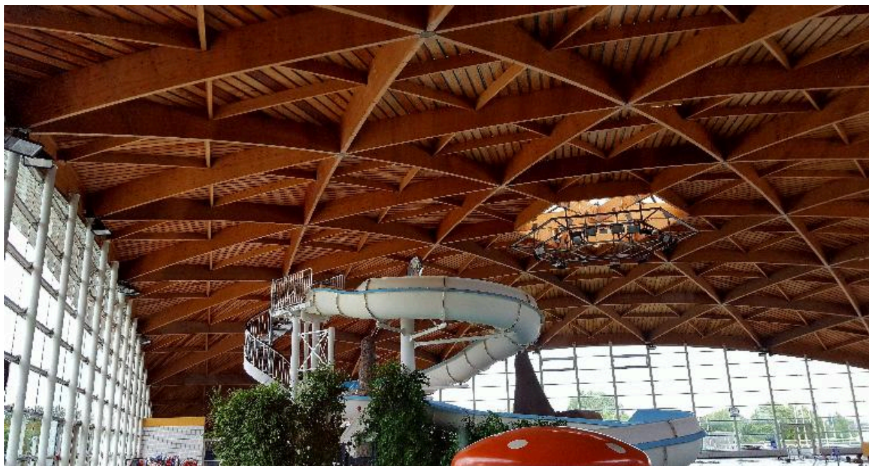
Vue de la voûte en bois lamellé collé.
