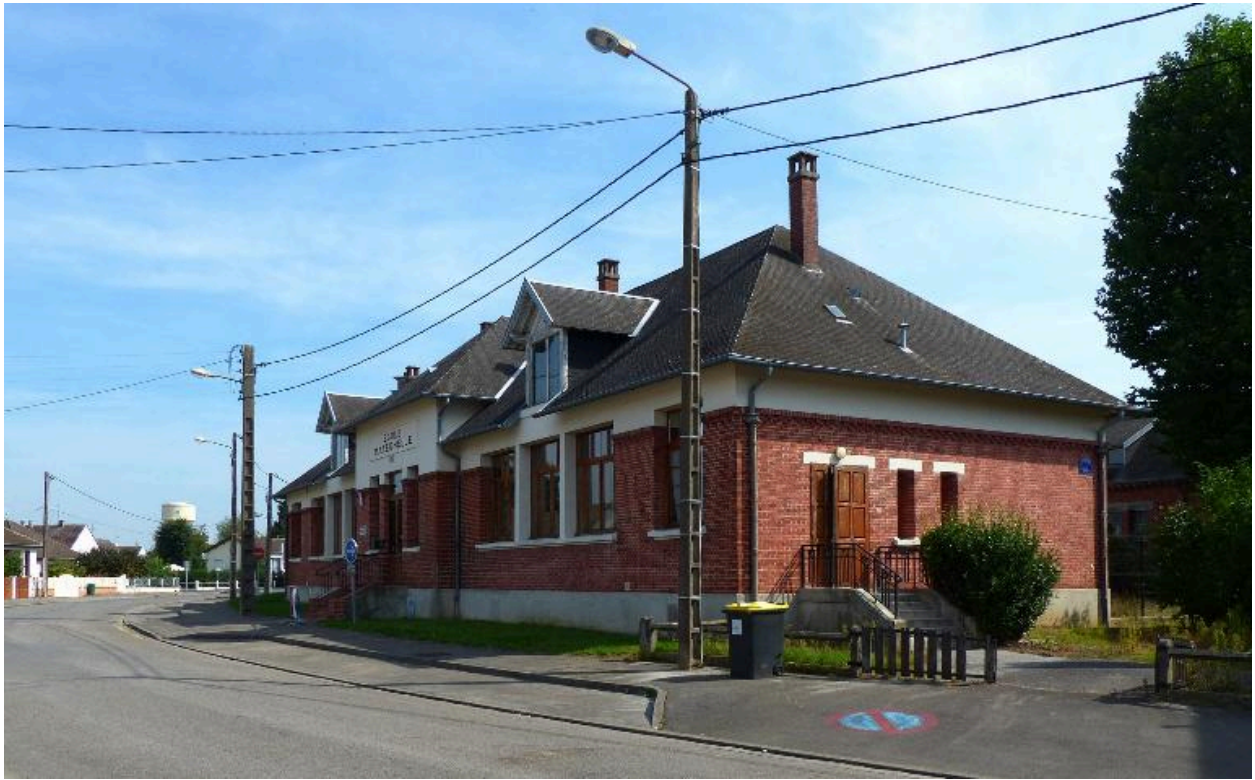
Vue depuis le boulevard des Déportés.
