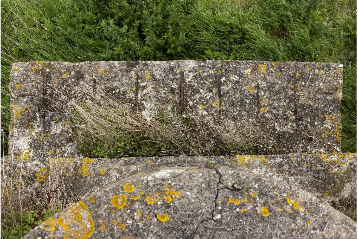
Banquette de tir à la verticale du support de mortier
