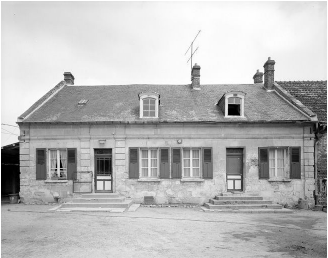
Logis. Élévation antérieure.
