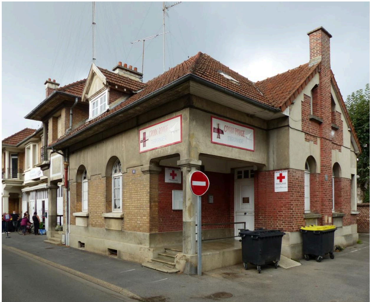
Vue de l'ancien dispensaire.
