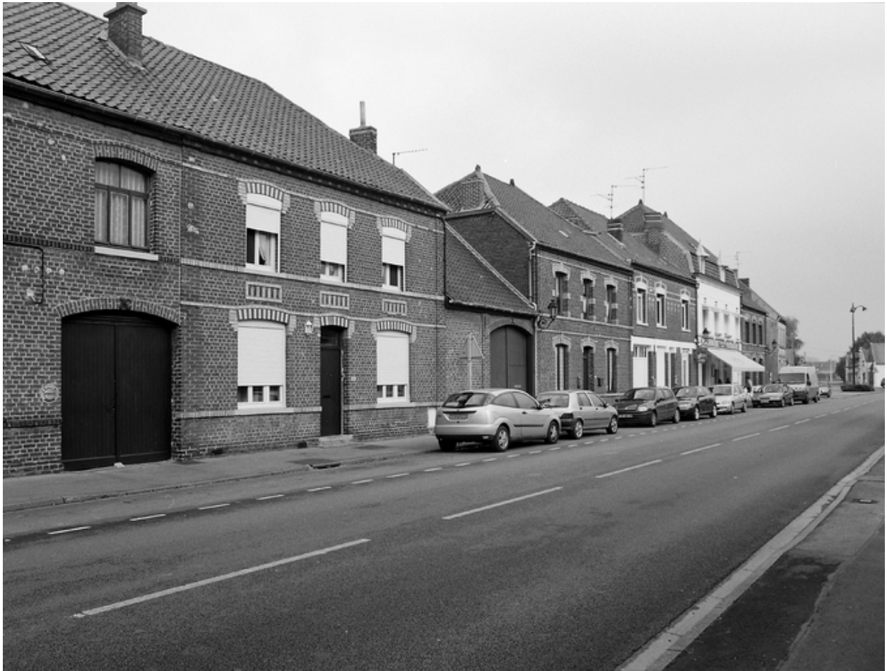
Alignement de maisons de bourg, rue de l'Eglise.
