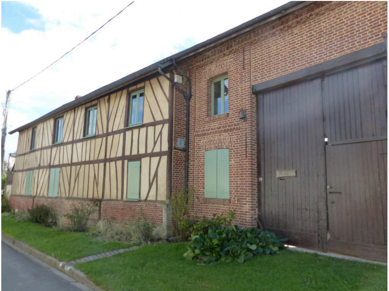
Façade sur rue de la ferme au n°18 Grande Rue, vue depuis le nord.
