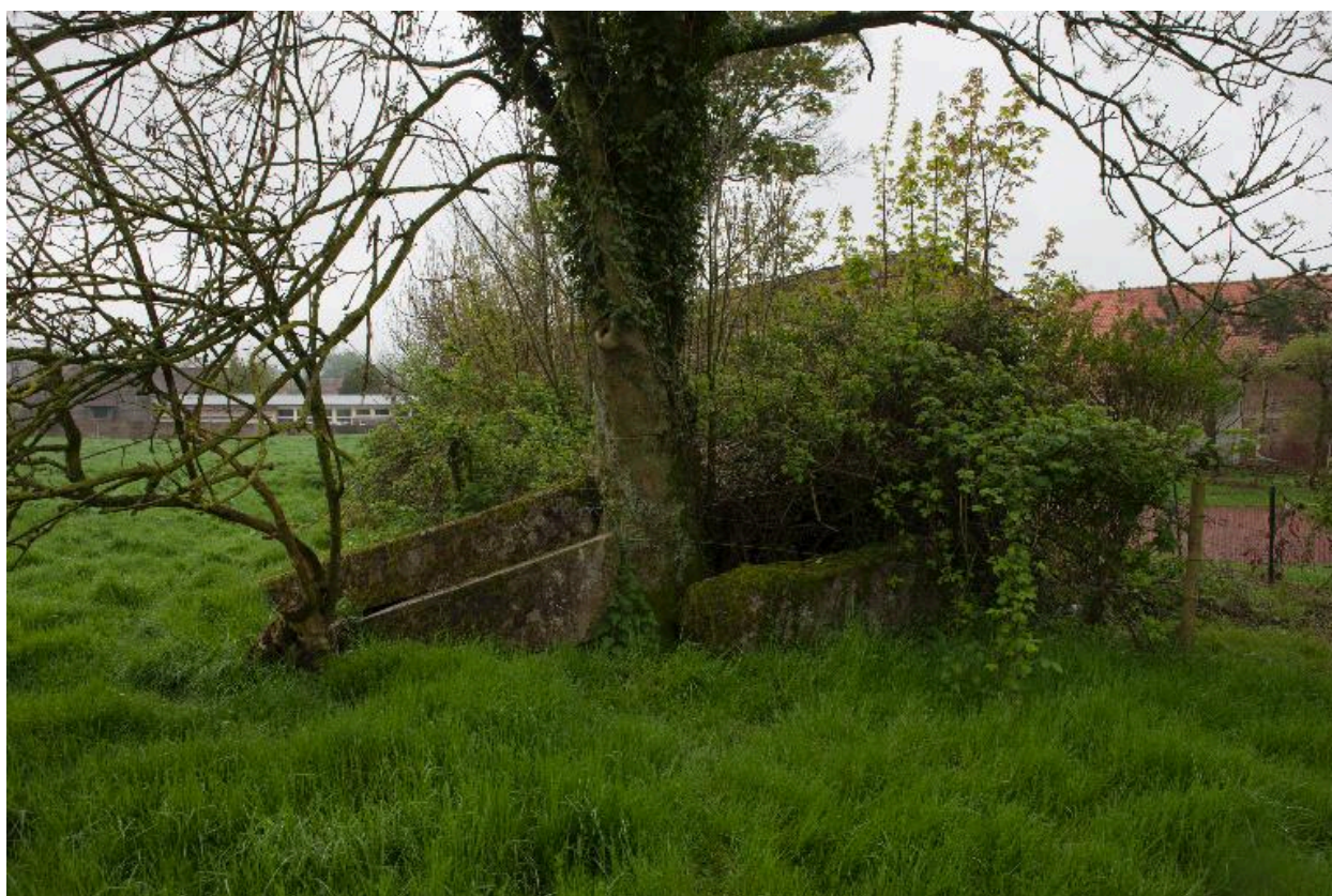
Bâtiment de stockage d'attente.
