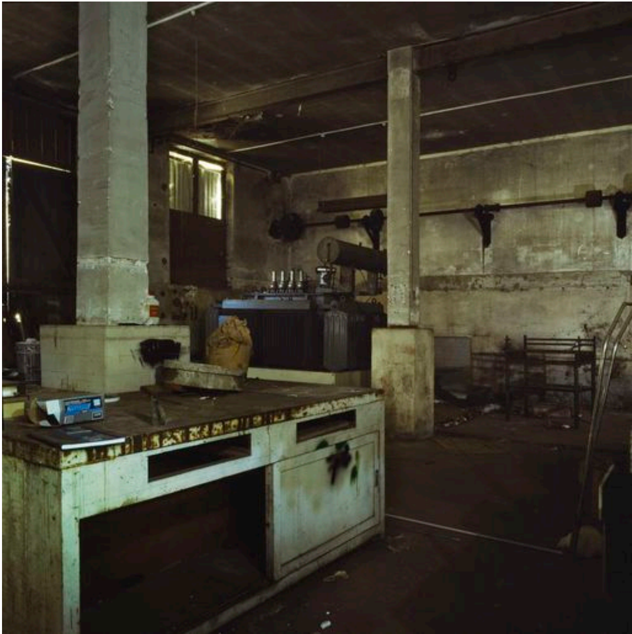
Laboratoire installé au sol-sol d'un des ateliers.
