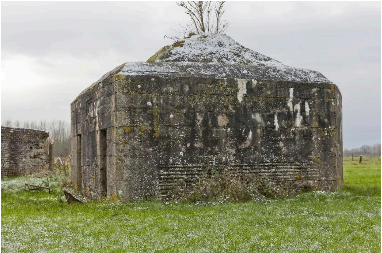
Casemate nord, vue vers le sud-ouest
