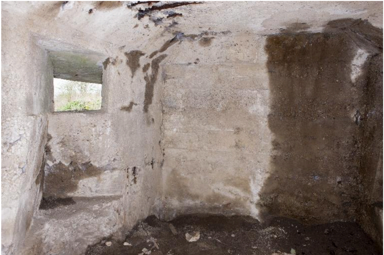
Seconde salle, élévation sud-ouest. Créneau de fusillade ou d'observation
