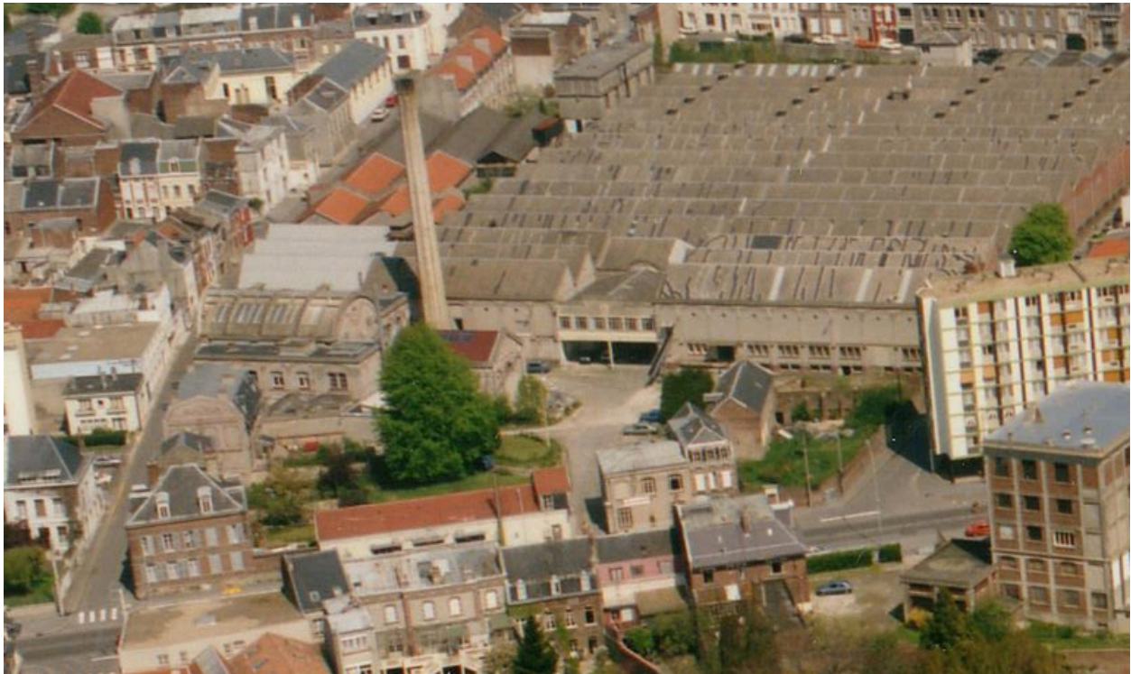
Vue aérienne du site entre 1988 et 1990 (BM Saint-Quentin).
