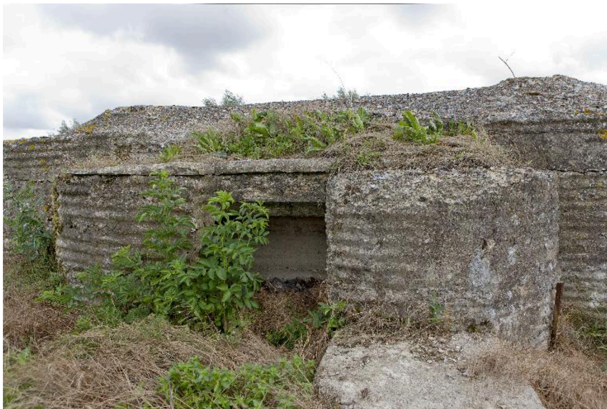
Entrée, vers le sud-est
