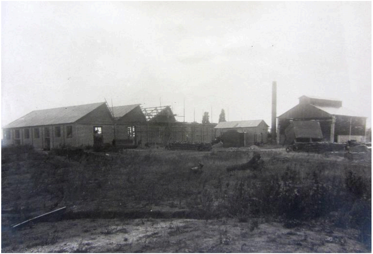
Vue d'ensemble des bâtiments de la tréfilerie en cours de construction, vers 1920 (AD Somme ; 10 R 625).
