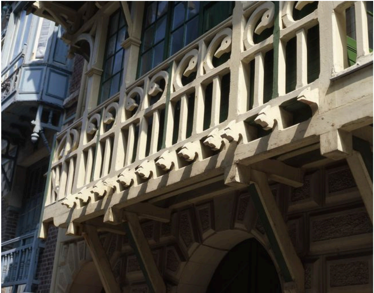
Détail d'un garde-corps en menuiserie (1er étage-carré).
