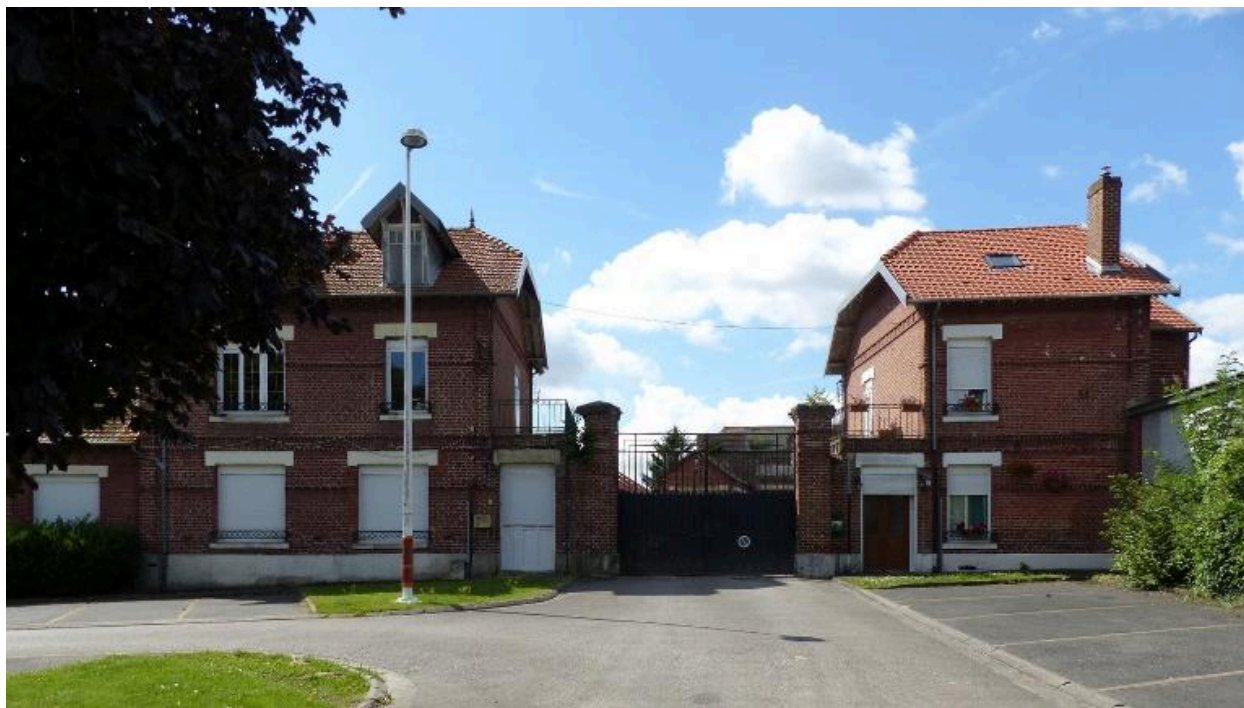
L'ancienne conciergerie et le logement du directeur.
