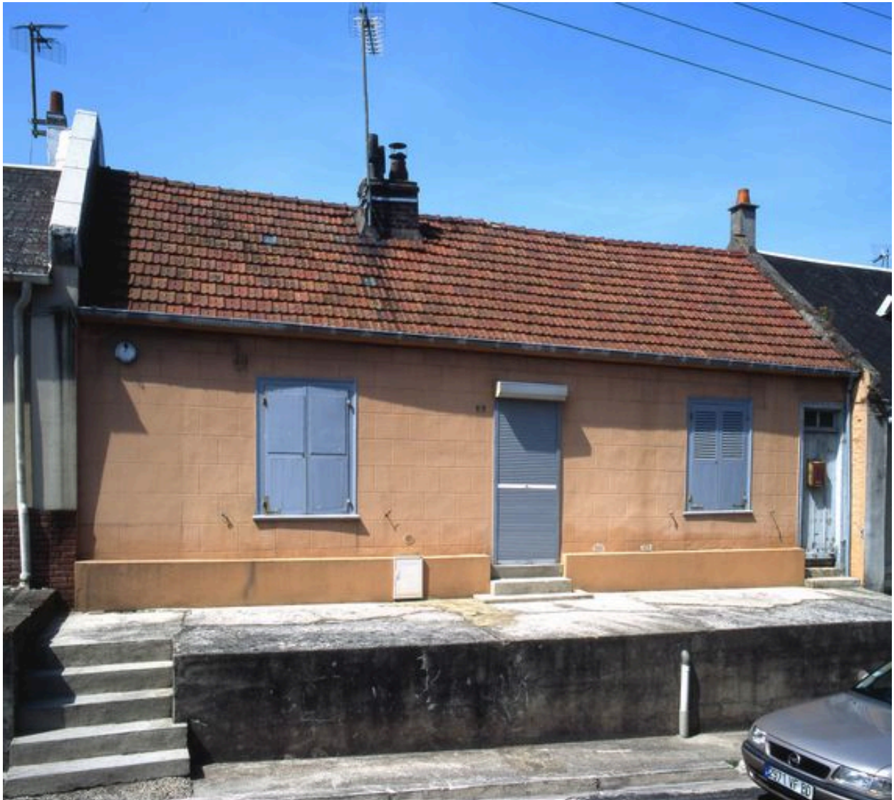
Maison ancienne, rue du Hamel (54).
