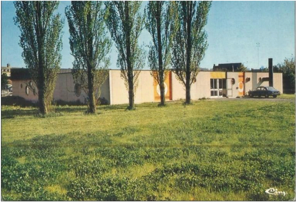
Façade d'entrée de la piscine "Plein Soleil", vers 1980, carte postale (coll. part.).
