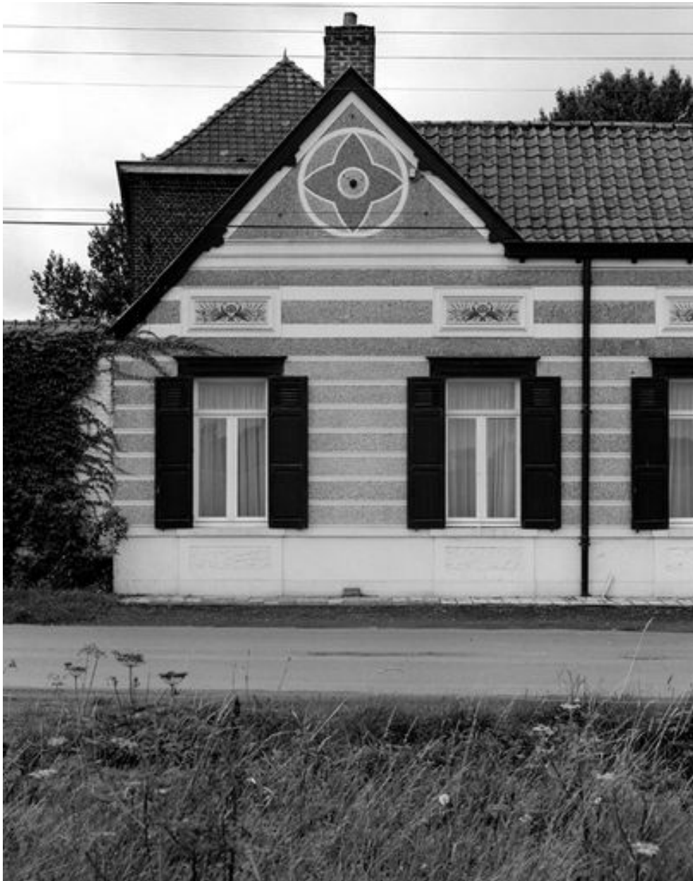
Détail de la façade sur rue du premier logis, cartouche en carreaux de céramique.
