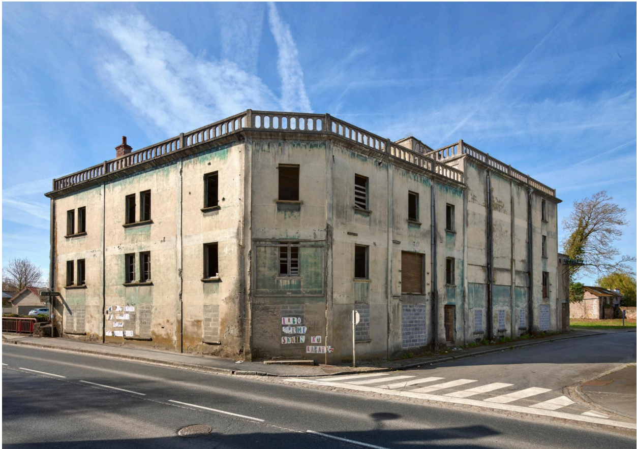
Vue d'ensemble nord-est de la minoterie donnant sur la rue Marin.
