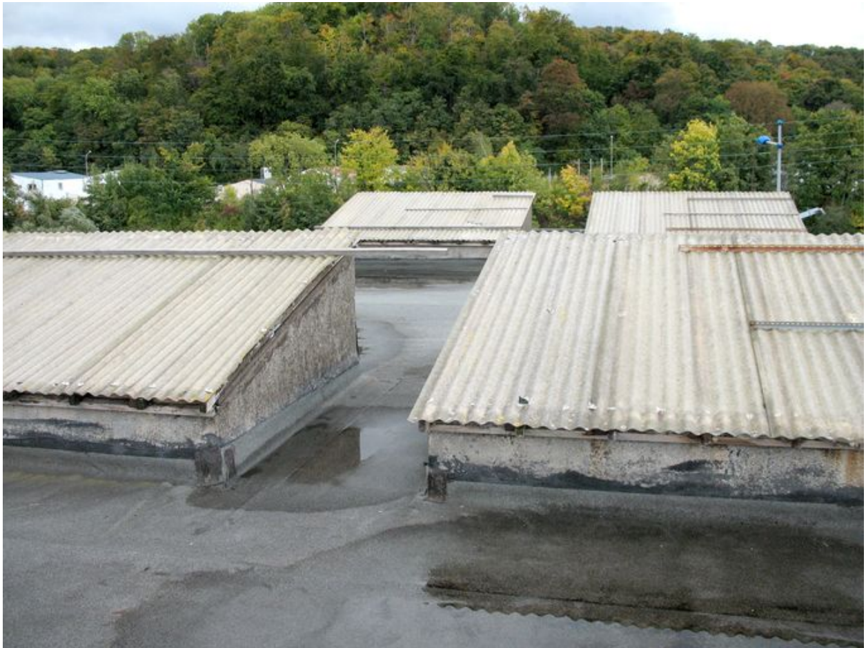
Toit et surtoits de la station de pompage.
